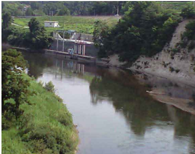
八天橋より頭首工を見る
