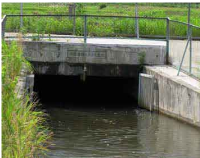
西部幹線トンネル出口
